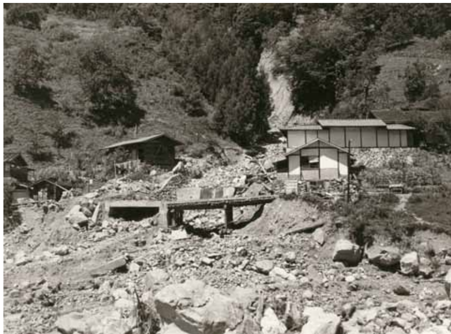
民家の背後の斜面の崩落と鹿塩橋に押し出した土砂
