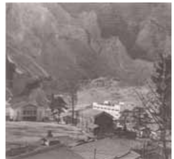
崩落の傷がまだ生々しい 崩落後の大西山。 手前は大河原中学校
