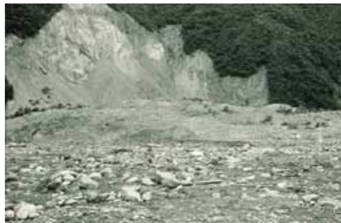
大西山の崩落現場
