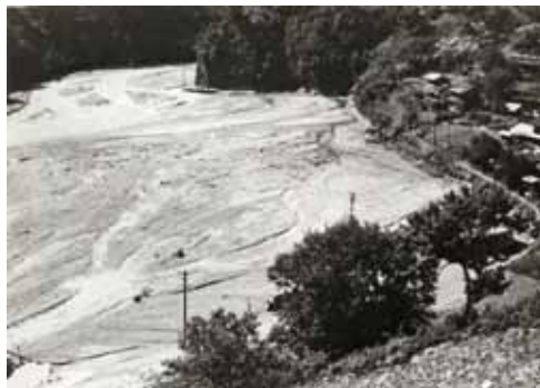
洪水で川幅が広がった小渋川とそこに積もった土砂
