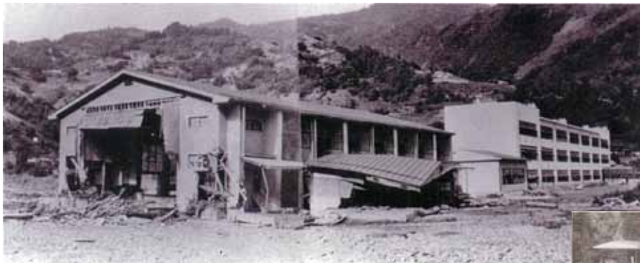
土砂崩壊の爆風で穴が開いた大河原小学校の体育館
