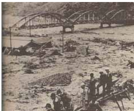
大鹿村小渋橋付近。桐の久保沢の氾濫
