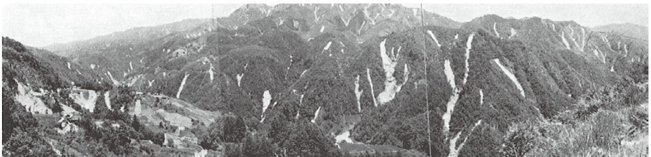
梅雨前線豪雨により至るところ荒廃した林地（上伊那郡中川村南向桑原地籍）
