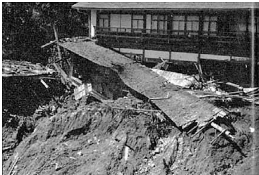
山崩れの影響で半壊してしまった四徳鉱泉。
