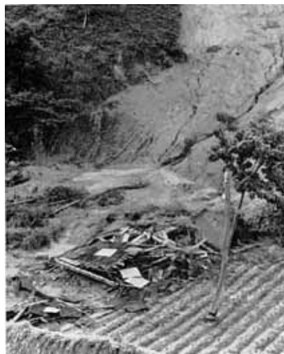
家を押しつぶしたなぎには無気味な亀裂が生じている。
