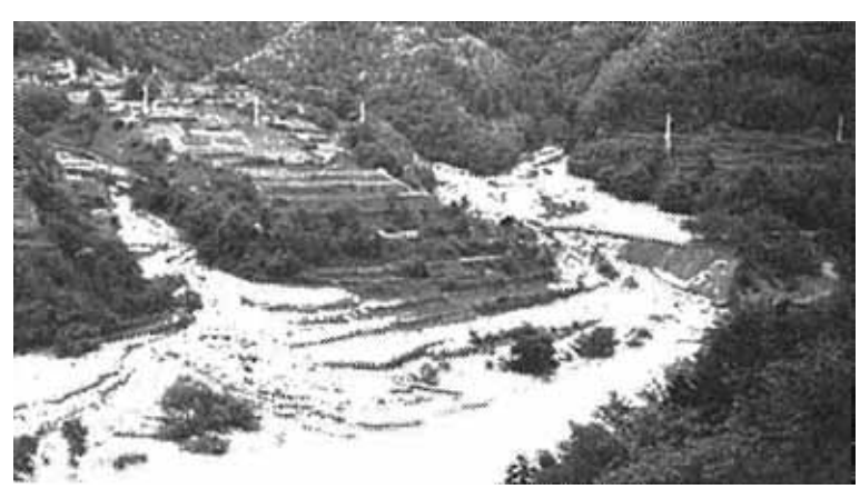
河川の氾濫や土石流で被災した日曾利地区
