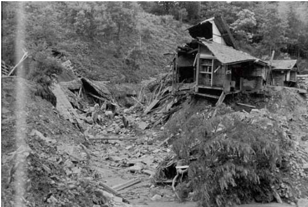
天竜川の氾濫により流失した民家
