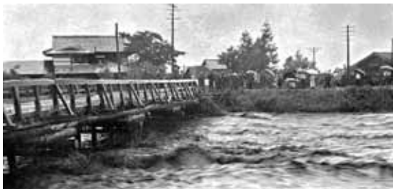
新宮川の濁流により流失寸前の新宮川橋
