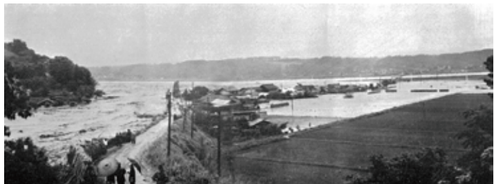
新宮川橋を流失し、氾濫で埋まった新宮川岸
