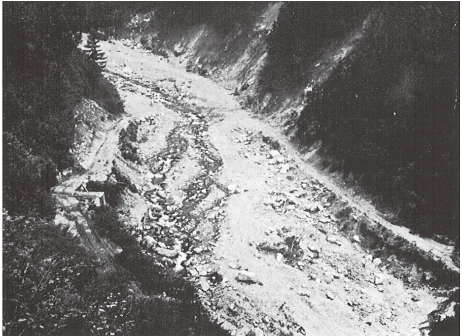
林道大松尾線被害状況 被害当時
