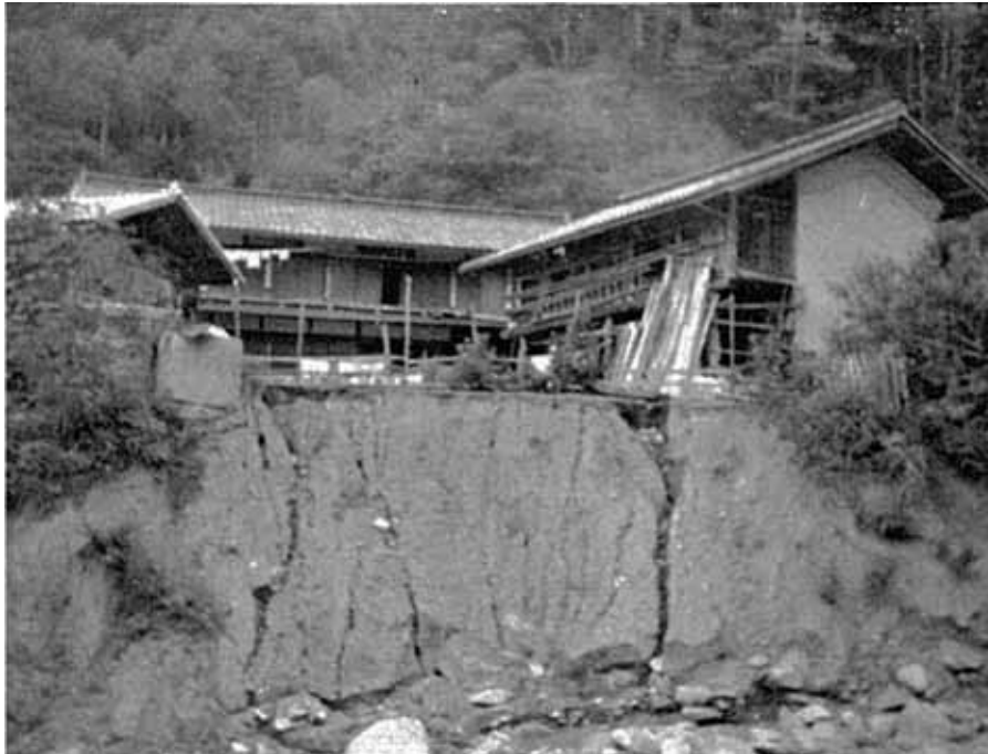
前庭まで濁流に洗われた危険になった大洞の家屋
