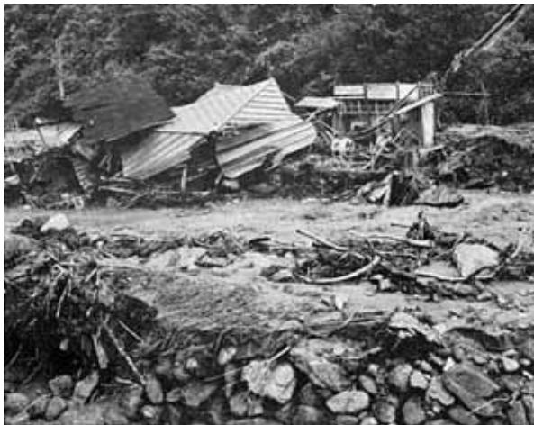
土石流により壊滅した上割新宮川発電所
