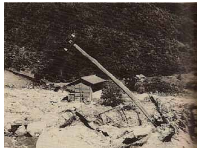
土石流によって埋まってしまった家屋と倒れた電柱
