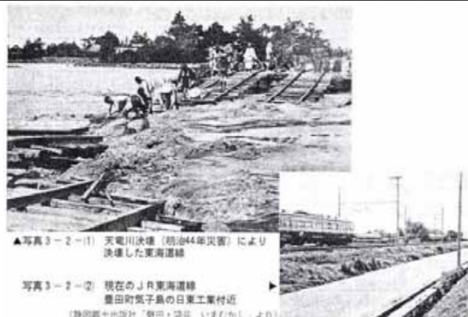
明治44年8月洪水により決壊した東海道線
