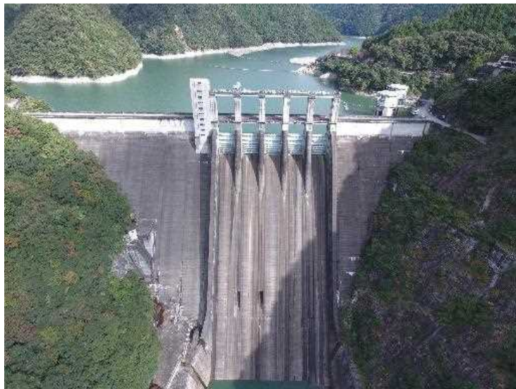
佐久間ダム（昭和31年完成）
