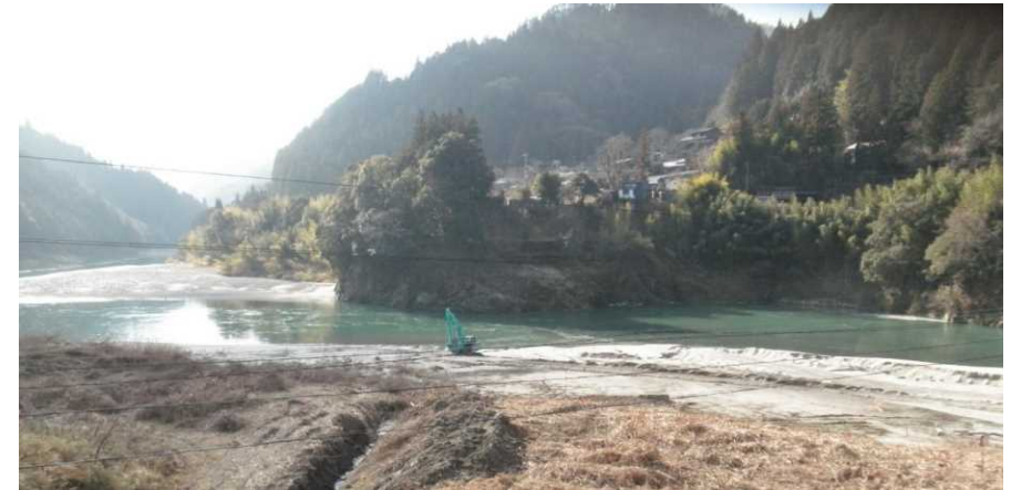
堆砂によるダムの機能低下の例（湖内の陸上掘削）
