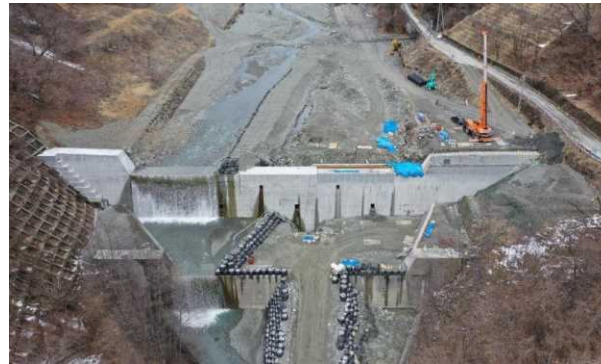
土砂生産元の例（荒川大崩壊地：長野県） 流出土砂対策（砂防堰堤の設置）
