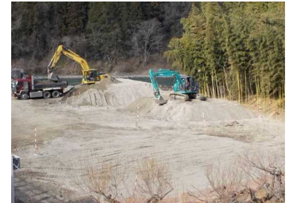
堆砂によるダムの機能低下の例（掘削土砂搬出）
