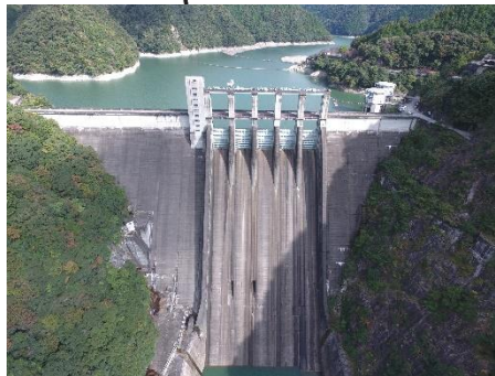
佐久間ダム（昭和31年完成） 平成28年10月撮影
