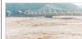
S57.8洪水：浜松市鹿島橋付 近
