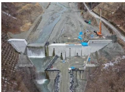
土砂流出対策 (砂防堰堤の設置)
