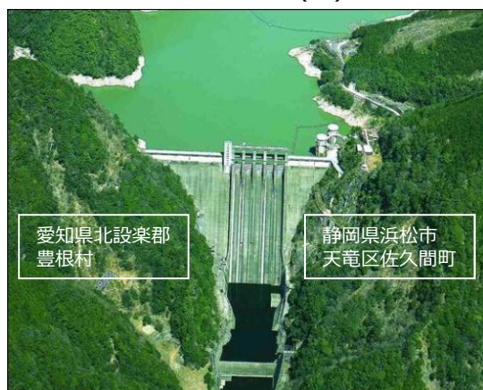
佐久間ダム（電源開発(株)S31完成）
