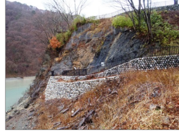
⑦ 中央構造線公園再整備
