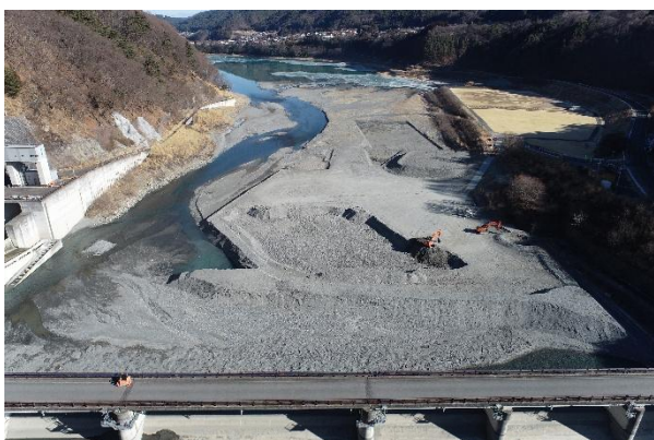
美和ダム 貯水池内掘削状況
