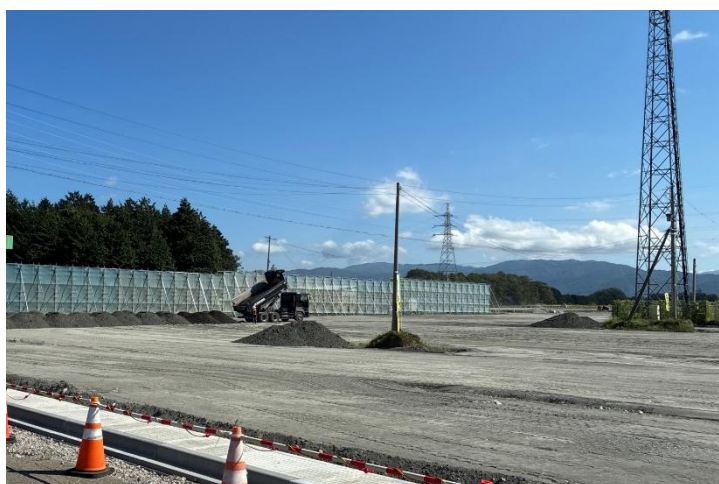
有効活用事例 伊那市東原工業団地
