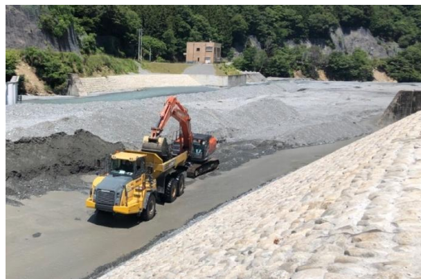
小渋ダム 分派湖内掘削状況
