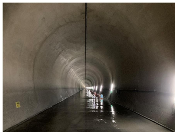
インバートコンクリート 補修完了
