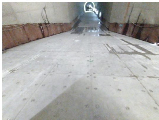
保護工 補修完了
