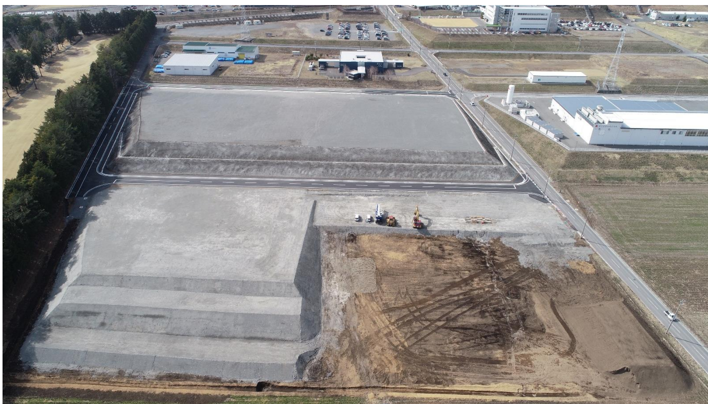
有効活用事例 工業団地造成に使用 (伊那インター工業団地)
