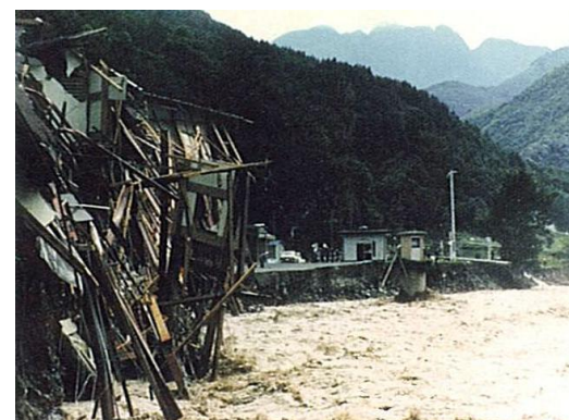
昭和57年洪水被害状況
