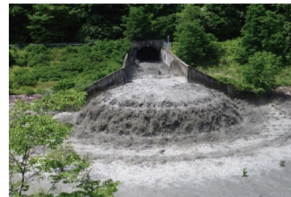
土砂バイパストンネルの運用状況
