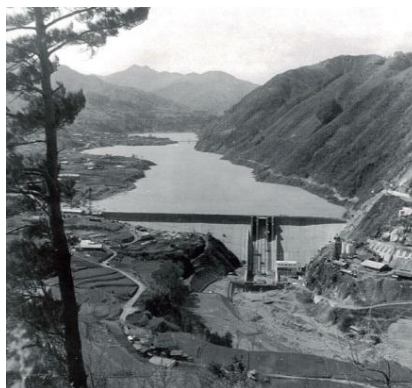
ダム完成時の状況
