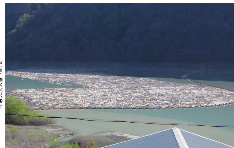
流木捕捉状況(令和2年5月1日撮影)
