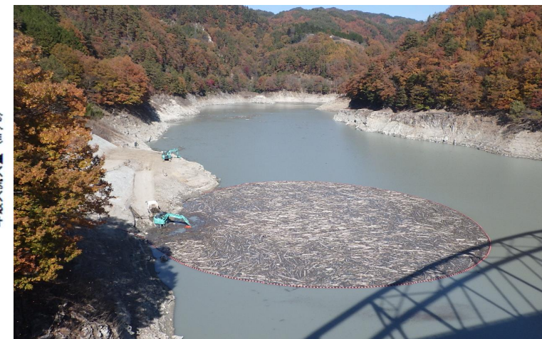
流木捕捉状況(令和2年撮影)
