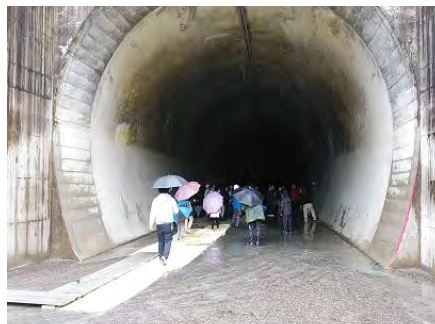
美和ダム土砂バイパス見学（3ダムツアー）
