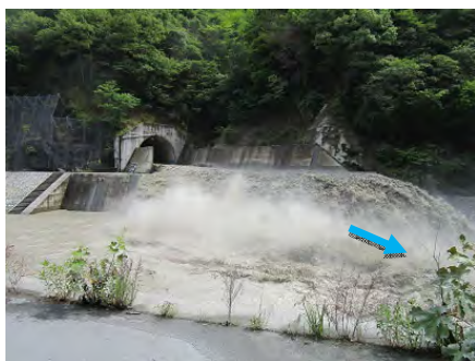
土砂バイパス放流状況 (R2.7出水 放流量約 170m 3 /s)
