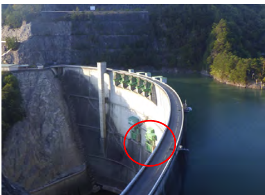
小渋ダム2号コンジットゲートの修繕
