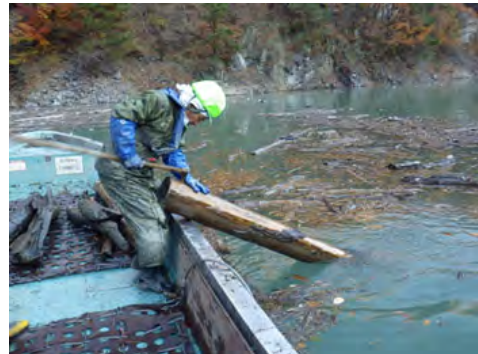
流木撤去状況
