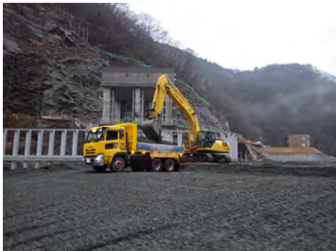
堆砂掘削状況
