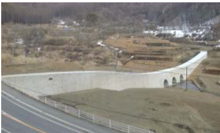
－景観に配慮した砂防ダム－
