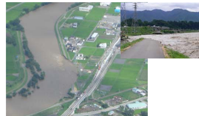
平成18年洪水時の箕輪町北島地先決壊の様子
