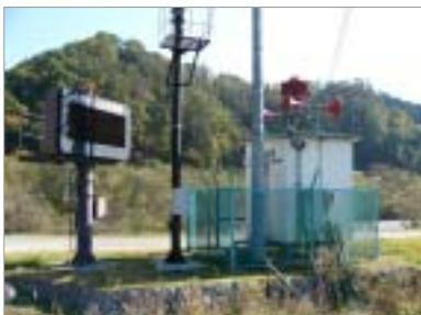
警報装置には、スピーカーとサイレン、それに場所によっては電光板が設置されています。川の近くや川に入っている人たちは洪水時のみならず平常時も、この警報内容に十分注意して、安全な河川利用に心がけてください。サイレンが鳴れば河川の水位が上昇しますので、川から速やかに上がってください。
