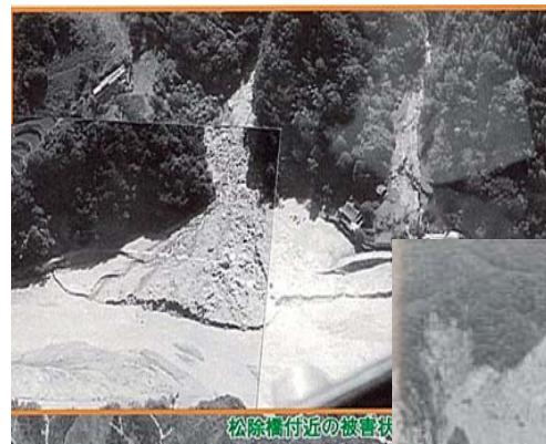
昭和36年洪水時の 土砂流出状況
