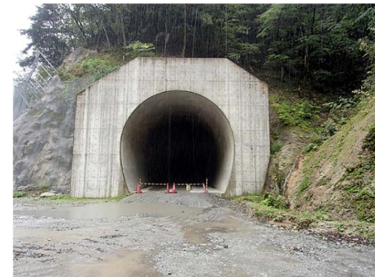
土砂バイパストンネル吐口
