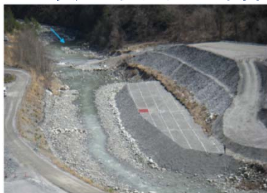
置土施工時(H23.3.23) (約3,800m 3 設置)
