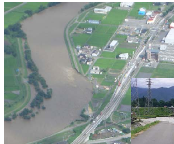
平成18年洪水時の箕輪町北島地先決壊の様子
