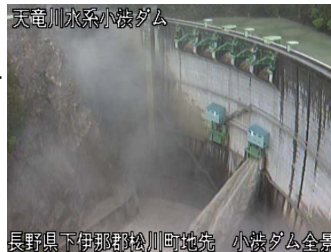
小渋ダム放流状況(5/21 12時)
