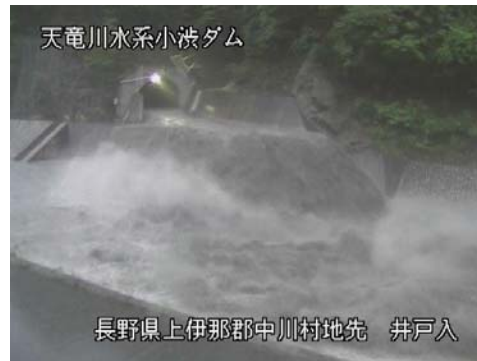
小渋ダム土砂BP放流状況(6/30 19時)
