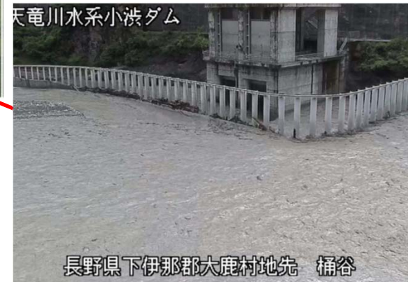
土砂バイパストンネル呑口（7月1日 11時頃）
