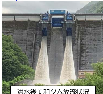
洪水後美和ダム放流状況 （7月1日7:20）
