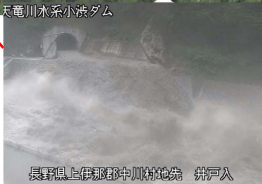
土砂バイパストンネル吐口（7月1日 11時頃） 土砂バイパス放流量 約170m 3 /s
