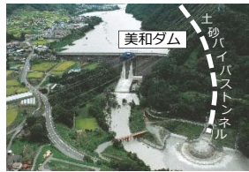
土砂バイパストンネル吐口
