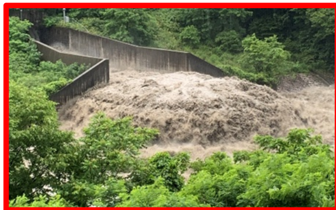
土砂バイパストンネル吐口（7月1日 7時頃） 土砂バイパス放流量 約206m 3 /s
