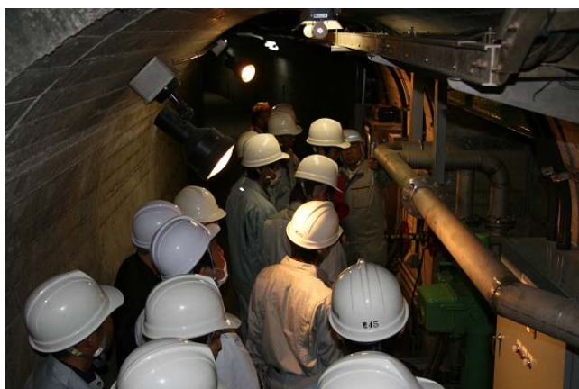
堤体内監査廊（点検用通路）
