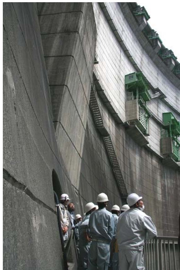
キャットウォーク（点検用通路）
