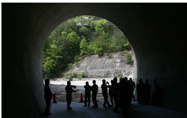
土砂バイパストンネル吐口（排出口）
