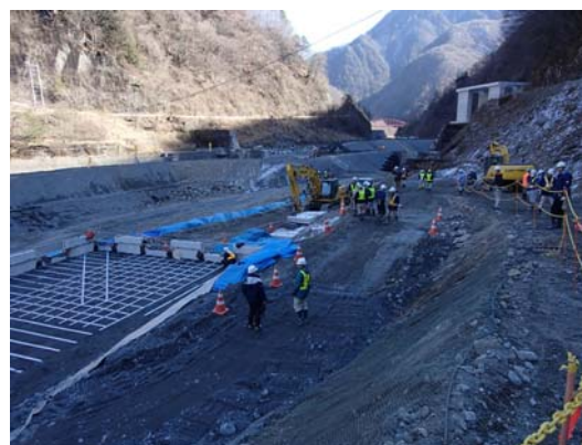
呑口整備工事パトロール
