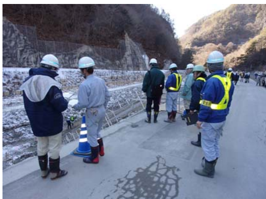
吐口整備工事パトロール
