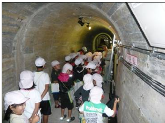
説明状況（ダム内部）
