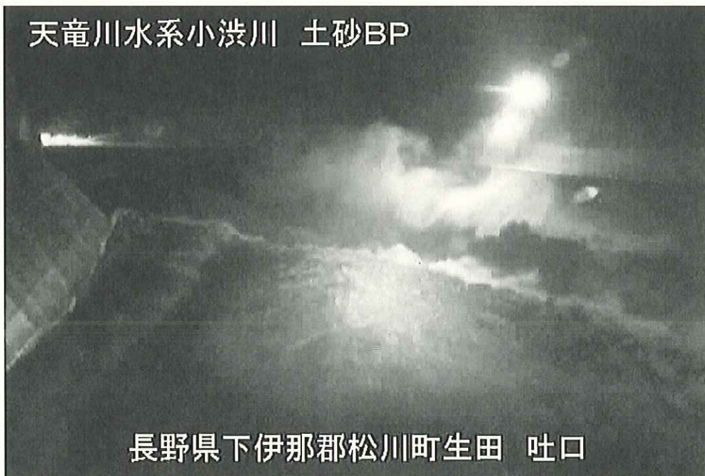
【土砂バイパストンネル 吐口】 放流中の状況 平成29年10月23日 4:30撮影 最大放流量 毎秒約180 m 3
