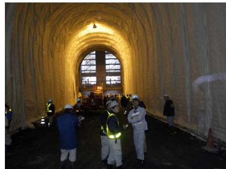
バイパストンネル内部
