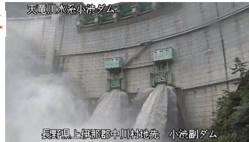
長野県上伊那郡中川村地先 小渋副ダム 小渋ダム放流状況(8月14日14時)
