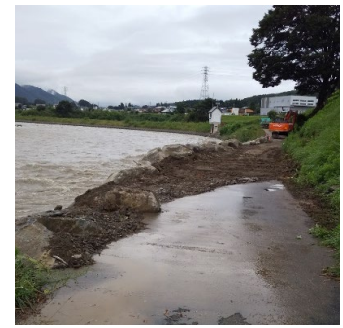
応急復旧完了
