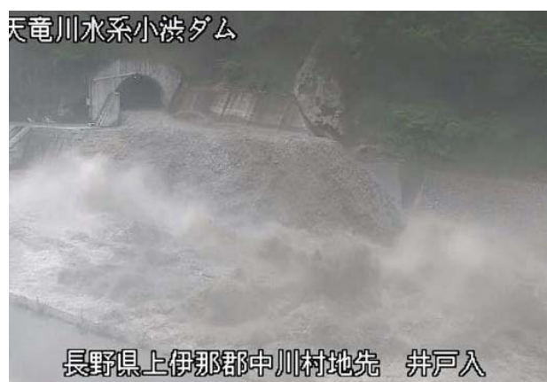
土砂バイパストンネル吐口 (7月1日 11時頃)
