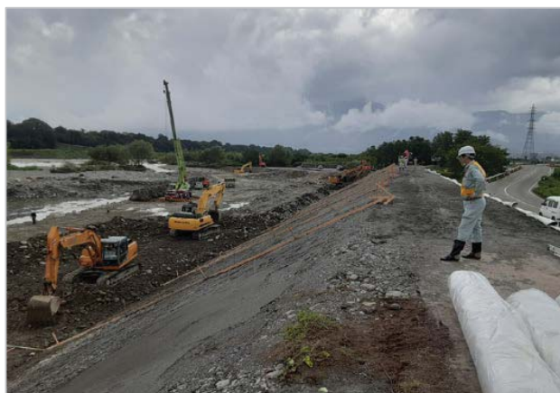
7月7日16:00 【復旧工事】 堤防盛土完成
