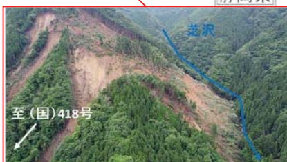
●天龍村足瀬 (土砂崩落)
