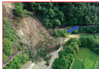
●喬木村加ヶ須 (土砂崩落)
