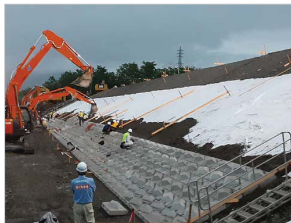
7月9日19:00 【復旧工事】 堤防を侵食から守る為の護岸設置状況
