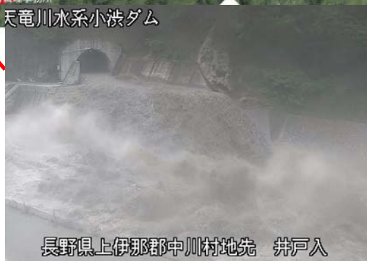
土砂バイパストンネル吐口（7月1日 11時頃） 土砂バイパス放流量 約170 \text{m}^3/\text{s}
