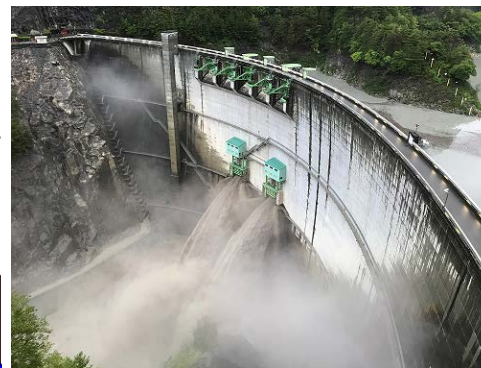
小渋ダム放流状況 (7/1 5時)
