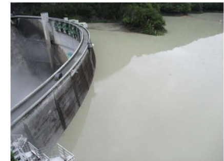
洪水後小渋ダム貯水池状況 (8月16日 8時)
