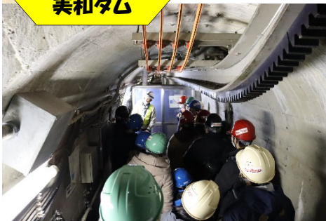
監査廊(ダムの中)
