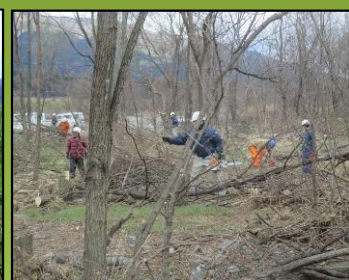
樹木伐採作業
