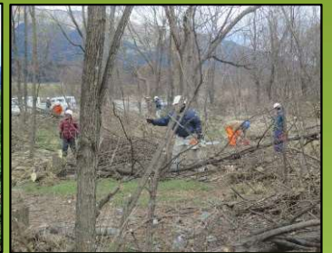
樹木伐採作業
