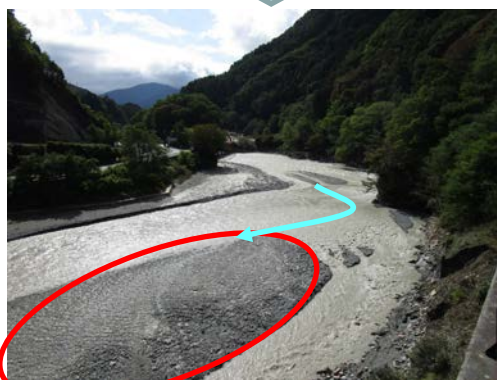
土砂堆積の発生
