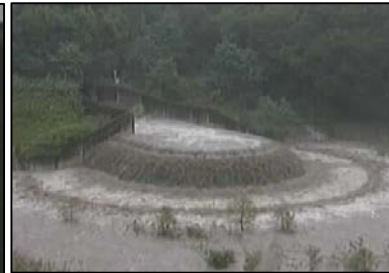
土砂バイパストンネル放流状況 (10月12日12:30)
