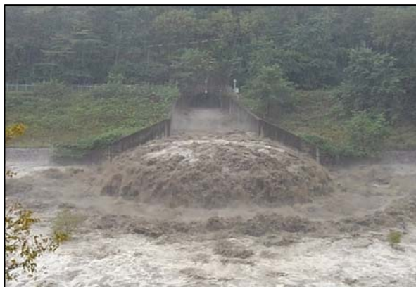
土砂バイパストンネル放流 (10月12日13:20)
