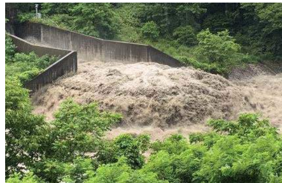
土砂バイパストネル放流状況(7月1日7:20)
