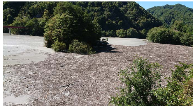
小渋ダム流木補足状況写真
