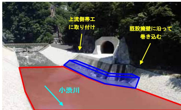
端部の取り付け
