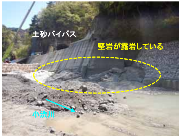
左岸側の露岩状況
