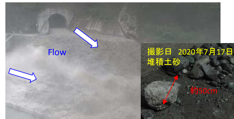
吐口部の状況(7/1 11時頃 放流量約170m 3 /s)
