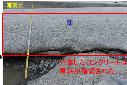
写真① 底張り工 分離コンクリート位置
