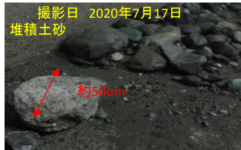
R2.7洪水でバイパスへ混入した土砂
