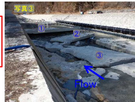
減勢工底張り工の確認状況
