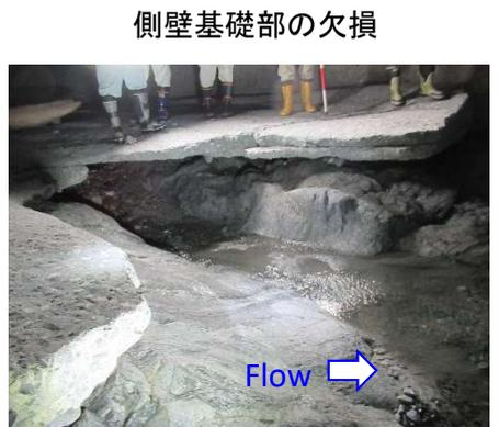
側壁基礎部の欠損
