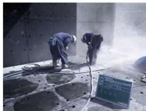
後施工アンカー用削孔
