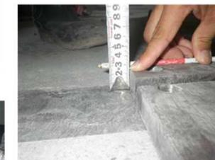
溶接開先と栓溶接用孔
