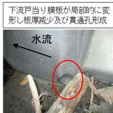
下流戸当り膜板が局所的に変形し板厚減少及び貫通孔形成
